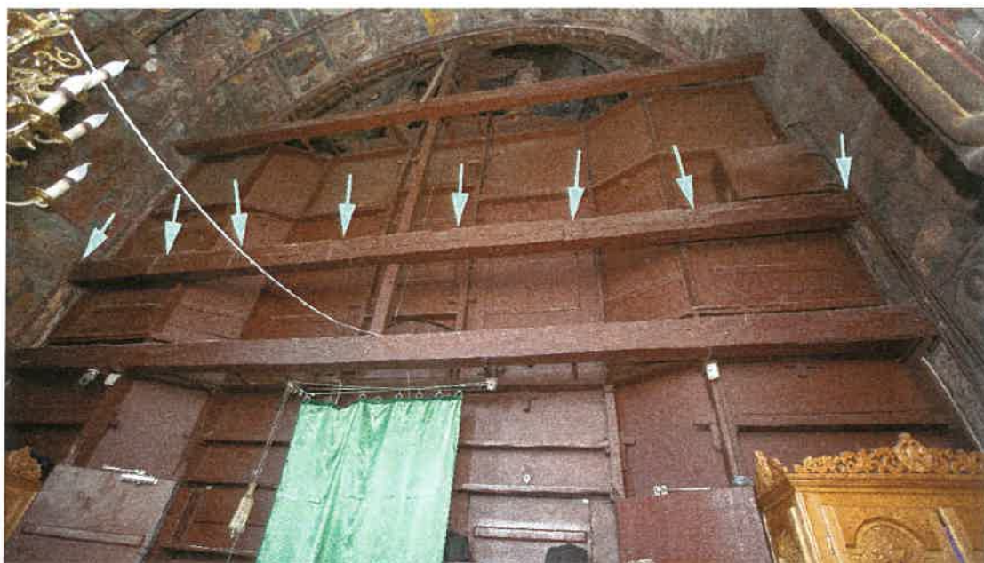
Grinda mediana cu 8 zone decupate de unde lipsesc stalpi de legatura
