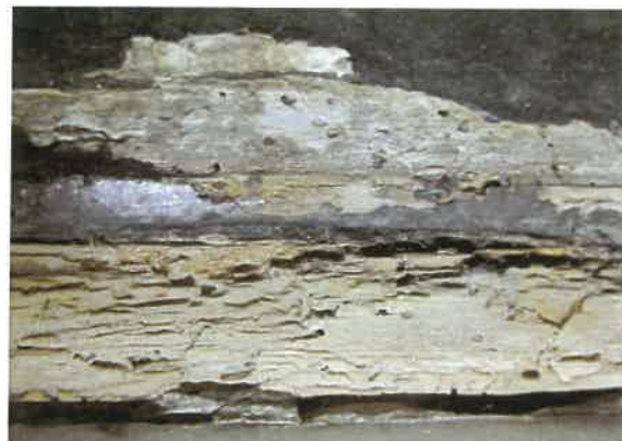
Soclu cu avansate degradari ale masei lemnoase pe toata aria longitudinala
