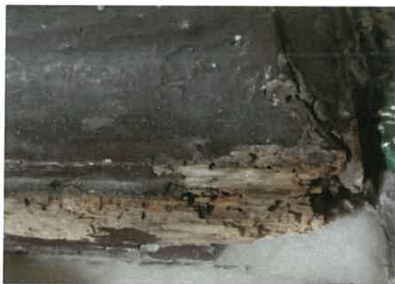
Soclu cu avansate degradari ale masei lemnoase pe toata aria longitudinala
