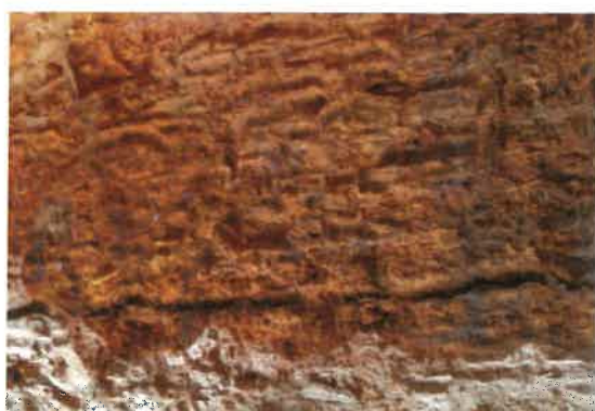
Consolidare suport lemn degradat, prin impregnare în mediu vacumatic
