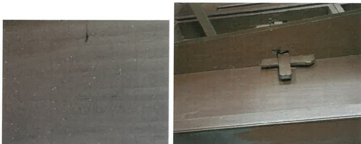
13. Orificii de zbor pline cu rumeguș proaspăt
