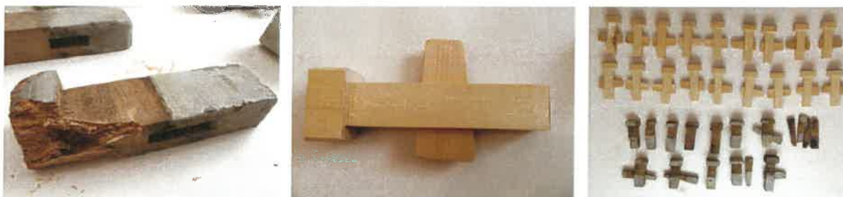
Refacerea penelor de fixare degradate (exemplu)
